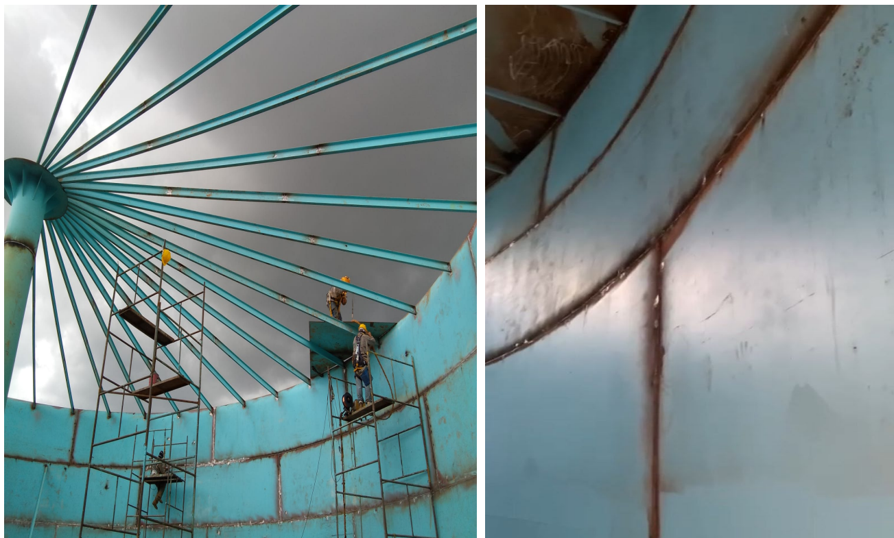
Figura 01: solda avaliada e preparada para o teste.
